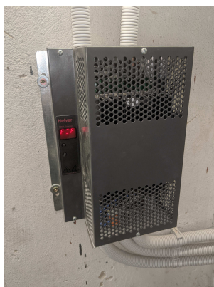
Obr. 1 Řídící zdroj HELVAR pro ovládání osvětlení sálu a pozice svítidel na stěnách sálu
