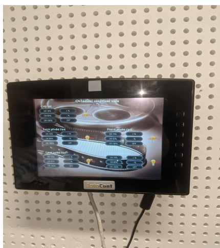
Obr. 2 Ovládací dotykové tablo v promítací režii – nahrazeno novým typem ovl. panelu
